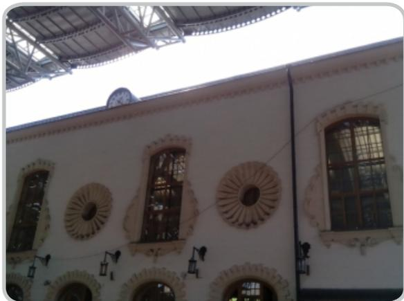
Монтаж объекта выполнен с применением монолитного поликарбоната Моногаль FR толщиной 12 мм., прозрачного цвета. Покрытие объекта должно максимально пропускать на перрон солнечный свет. И надежно защитить пространство от дождя и снега. Противоударные свойства Моногаль и его способность не разбиваться играют важное значение при выборе материалов для сооружений с большим человеческим потоком.
