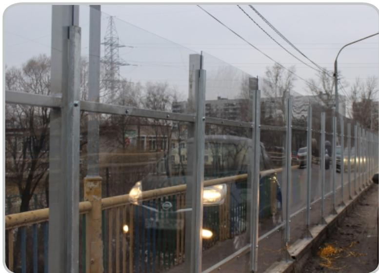
Монтаж объекта выполнен с применением монолитного поликарбоната Моногаль толщиной 10 мм., прозрачного цвета. Данный объект предназначен для защиты пешеходов от брызг проезжающих машин. А также от возможных ударов при автоавариях. В тоже время защитный экран не должен закрывать исторический, важный для города вид на Гуслицкий Спасо-Преображенский монастырь.
